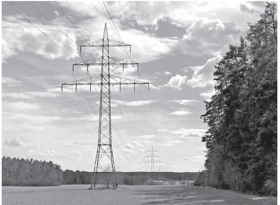
Die Masthöhe der zwischen Bauhof und Furth in Schwanstetten verlaufenden 110 kV-Freileitung beträgt etwa 35 m. Ein ganz anderes „Kaliber“ dagegen ist der Standardmast für die geplante 380 kV-Höchstspannungsleitung mit etwa 65 m Höhe.
