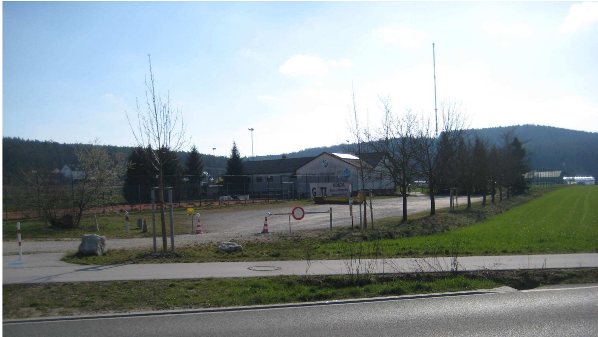
Abbildung 8: Blick über den südlichen Geltungsbereich Richtung Heidenberg
