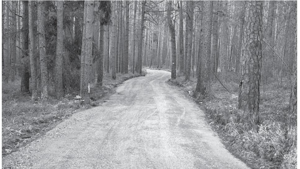
Recycling-Asphalt aufgetragen, profiliert, gewässert und verdichtet: Die „neue“ GVS
