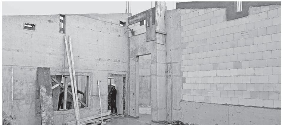
*In einem der Klassenzimmer der ersten Klasse sieht man an der Oberkante der Mauern bereits die Dachneigung des künftigen Walmdachs – in diesem Fall nach Norden und Westen.*
