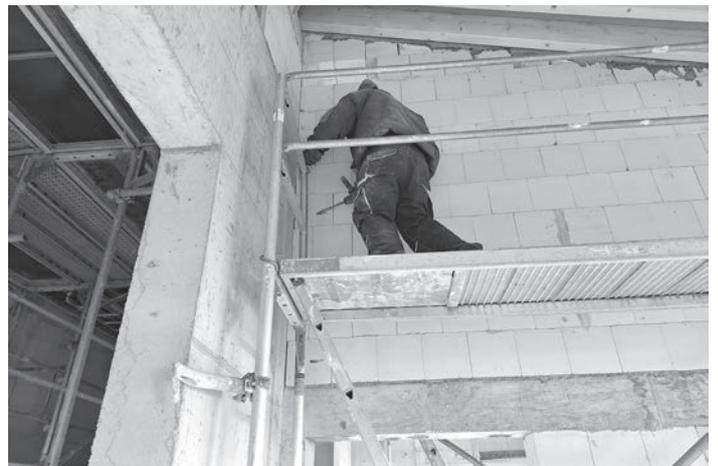
Die Zimmerleute bereiten derzeit die Innenverkleidung vor. Die Lattung oben auf dem Dachstuhl kommt demnächst dran. Außerdem bohren die letzten Rohbau-Arbeiter einige notwendige Durchlässe in die Wände und führen Feinarbeiten am Beton aus (Bild).
