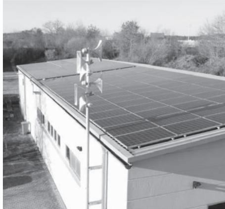
Auf dem Feuerwehrhaus Aurachhöhe wurde bereits ein Digitalsirene eingebaut, die verschiedene Tonsignale und Durchsagen ermöglicht. (Foto:ropi)
