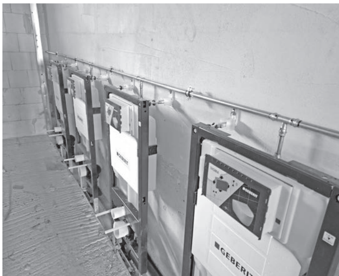
Mädchen-Toiletten im ersten Stock: Vier moderne Spülkästen, die durch Trockenbauwände verborgen sein werden, sind bereits gesetzt. Die Zuleitungen aus Edelstahl oben drüber sind ausgesprochen filigran gearbeitet.
