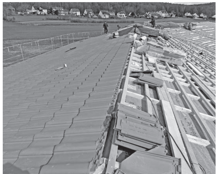
Das Dach der neuen Grundschule in Kammerstein-Neppersreuth war Anfang April auf der Nordseite bereits fertig mit Dachziegeln gedeckt. Mitte April sollen die Dachdecker komplett fertig sein.
