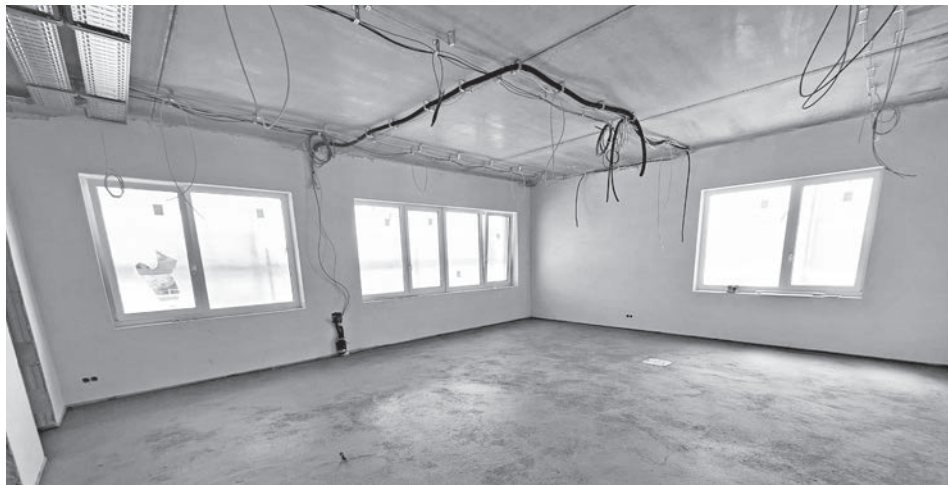
Mit dem fertigen Estrich, Putz und der ersten Farbschicht schaut das Lehrerzimmer im Erdgeschoss schon ganz manierlich aus.
