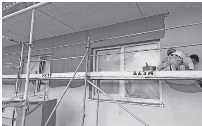
Nach dem Anbringen der Dämmung wird die Außenwand verputzt, hier der Eingangsbereich auf der Südseite unter dem Vordach.
