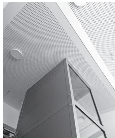
Sogar im Treppenhaus ist die Akustikdecke fertig, und die Deckenlampen sind platziert. (Foto: Wolfram Göll)
