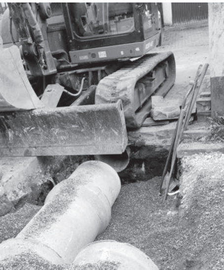
Der erste Streich erfolgte bereits 2024: Die Sanierung der schwer beschädigten Mischwasserkanäle nahe der Grundschule in der Nördlinger Straße und im Leitenweg. Hier mussten eingebrochene Rohre ausgetauscht werden. Nun, im Frühjahr 2026, kommen die leichter beschädigten Kanalabschnitte in Barthelmesaurach dran. Dazu müssen keine Gräben mehr ausgehoben werden. (Foto: Roberto Croci)
