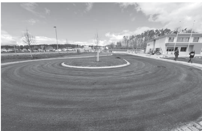
Die Bus-Wendeschleife wurde Anfang der Karwoche asphaltiert.
